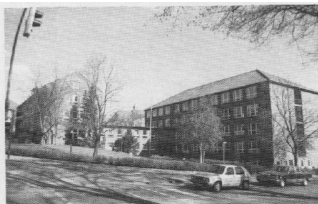
Gebäude Schützenkuhle 20-24, jetzt Fachschule für Technik und Gestaltung
